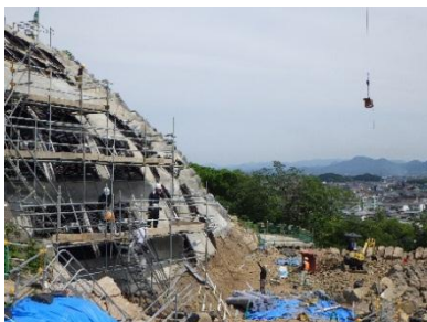
【②三の丸のグラウンドアンカー】
