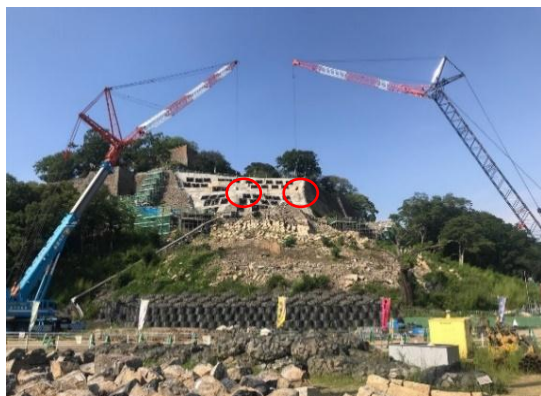
【2台のクレーンが同時に石を吊り上げている様子】
