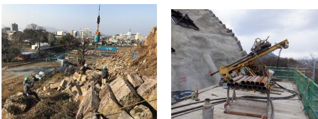
【崩落石材回収とグラウンドアンカー削孔の様子】
