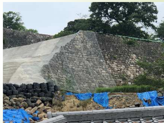
三の丸南面ロックネット
