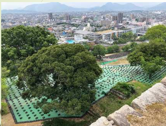
三の丸上部シート張り
