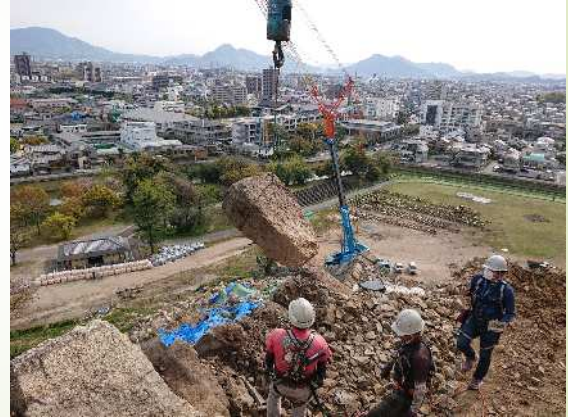
三の丸南面石垣撤去
