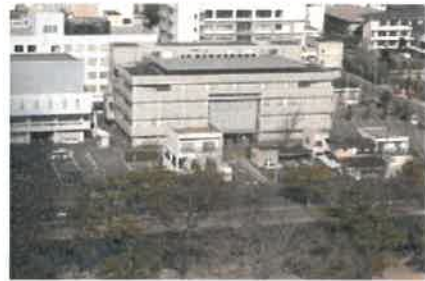
▲屋上施設が直視されないように工夫している
