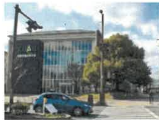
▲建物正面の入口周りにゆとりある空間を確保し、高木をシンボリックに植栽する
