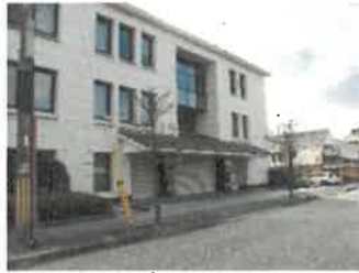
▲隣接するまち並みと調和させるように低彩度色を用いている
