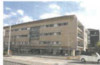
▲屋上施設を屋根やパラペット等により隠したデザインにしている
