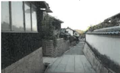
石材を用いた基礎や塀（本島）
