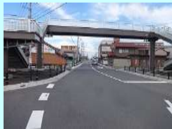
【道路】東汐入川周辺市
