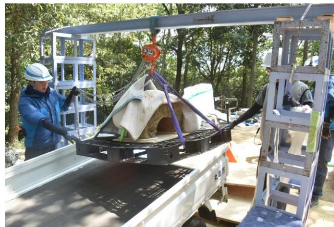
写真5 門型クレーン設置状況（北より）
